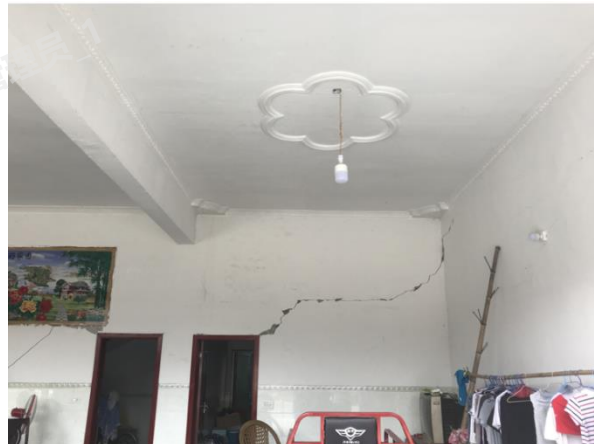
砌体结构构件裂缝
