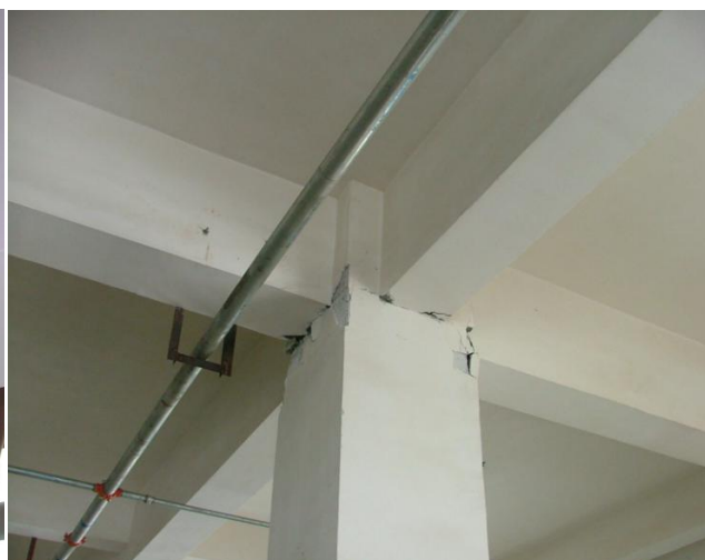
混凝土结构构件裂缝
