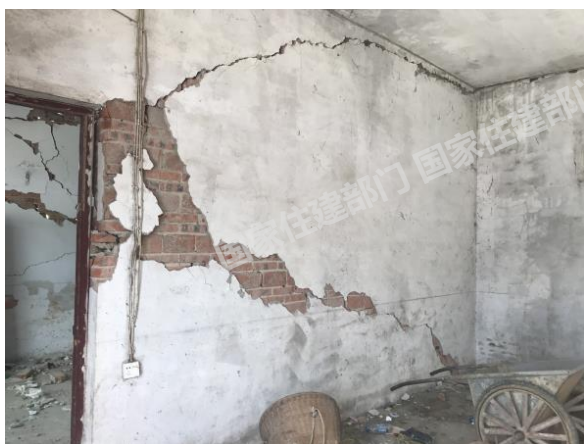
砌体结构构件裂缝
