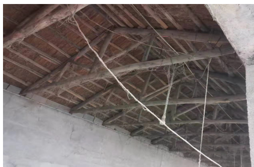
木屋架屋盖（无剪刀撑）
