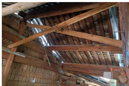
加设剪刀撑的木构架
