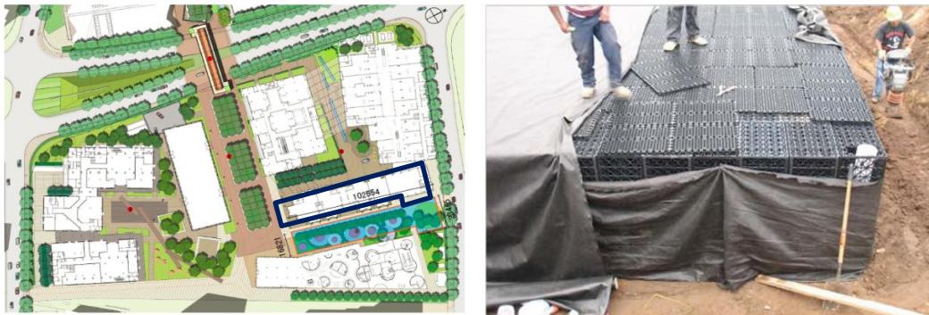
图 F4-10 城市最佳实践区南区绿地增渗系统实景图
