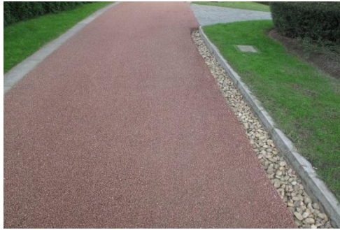
图 F4-19 透水性彩色沥青路面实景图
