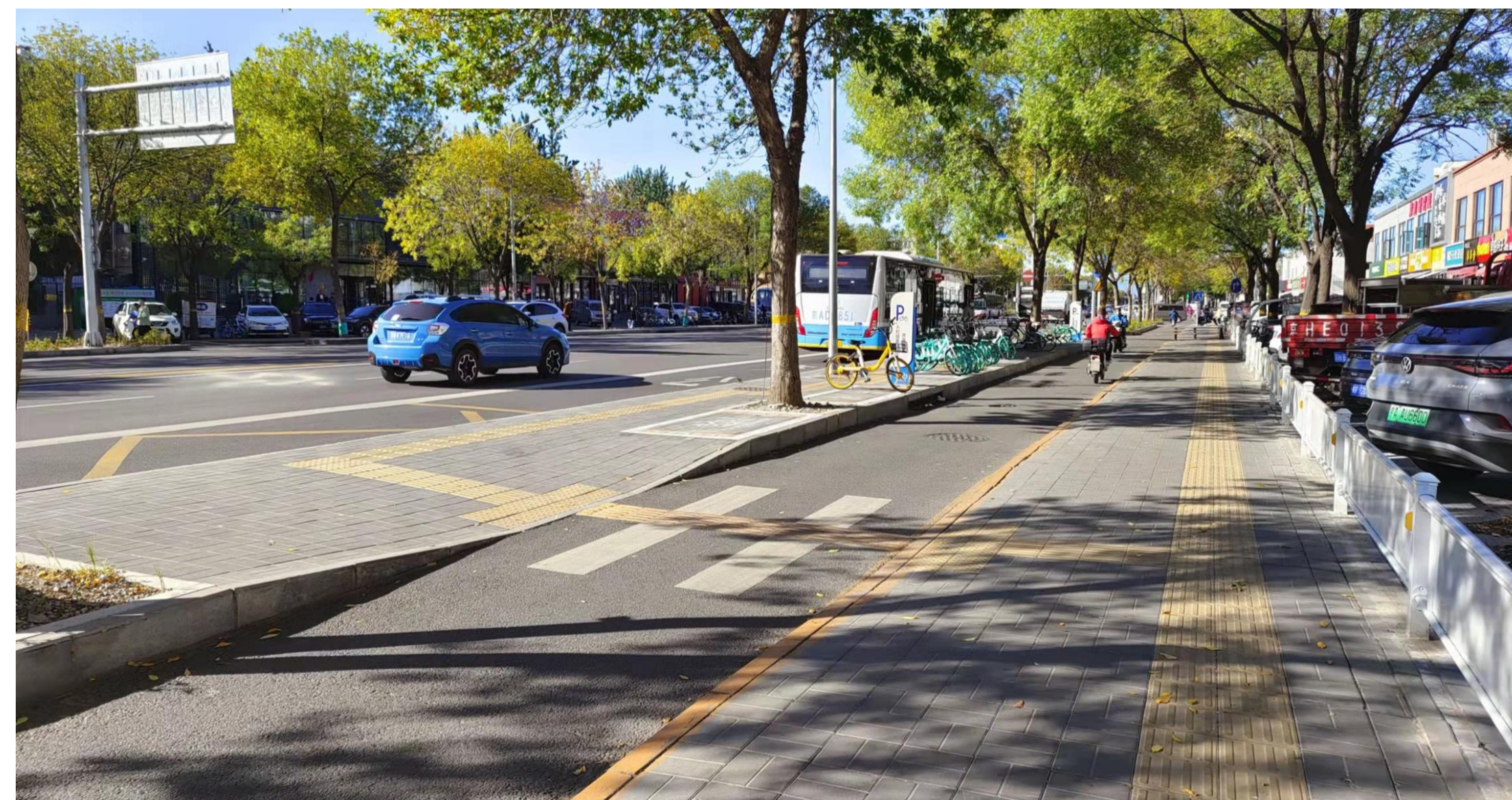
人行横道两端通过改造设置缘石坡道
