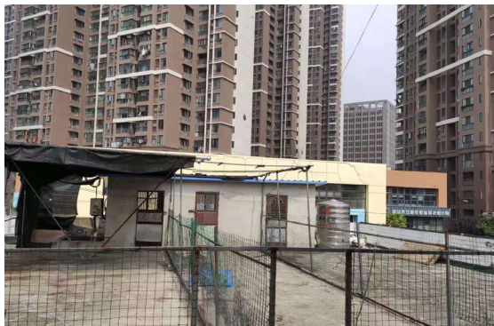
足球场建设前
