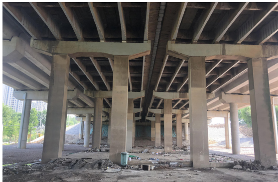
足球场建设前
