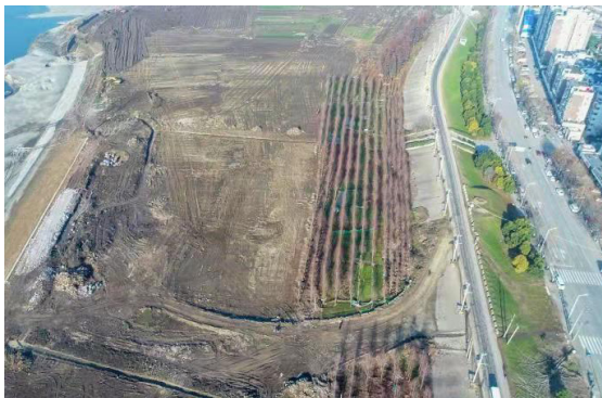
足球场建设前
