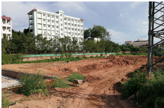
足球场建设前
