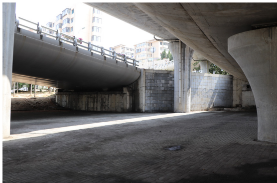
足球场建设前
