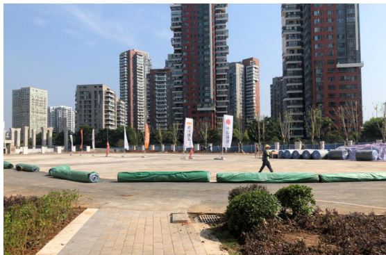
足球场建设前
