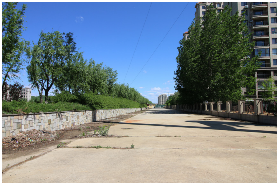
足球场建设前
