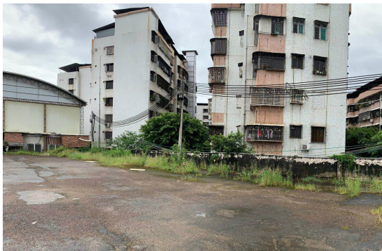
足球场建设前
