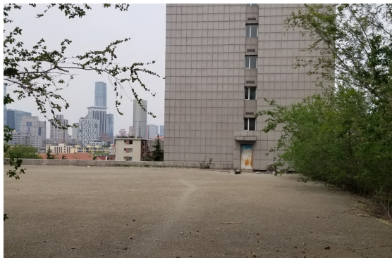
足球场建设前屋顶原貌
