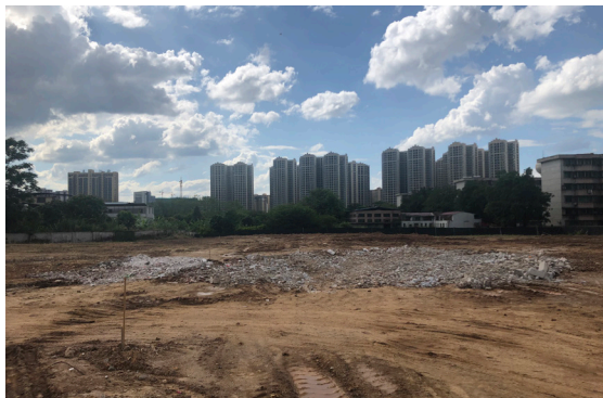
足球场建设前
