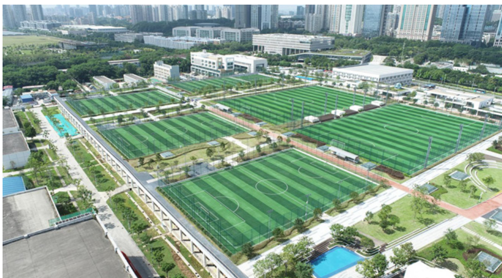
污水处理厂上盖足球场建成后鸟瞰
