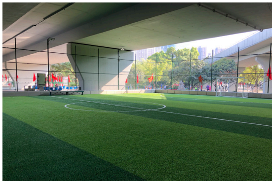
桥下足球场建成实景
