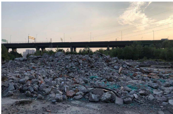
足球场建设前
