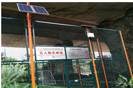
太阳能照明系统
