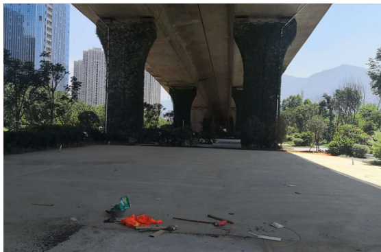
足球场建设前桥下空间
