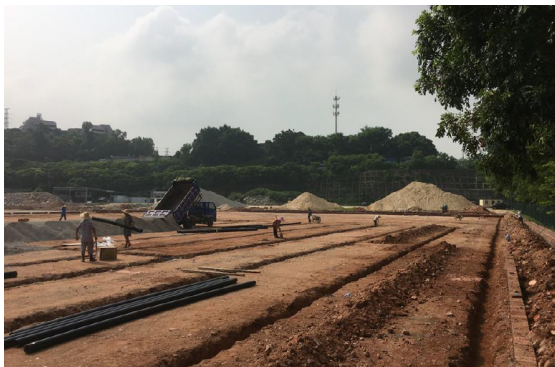
铺设根层通风和温度调节系统
