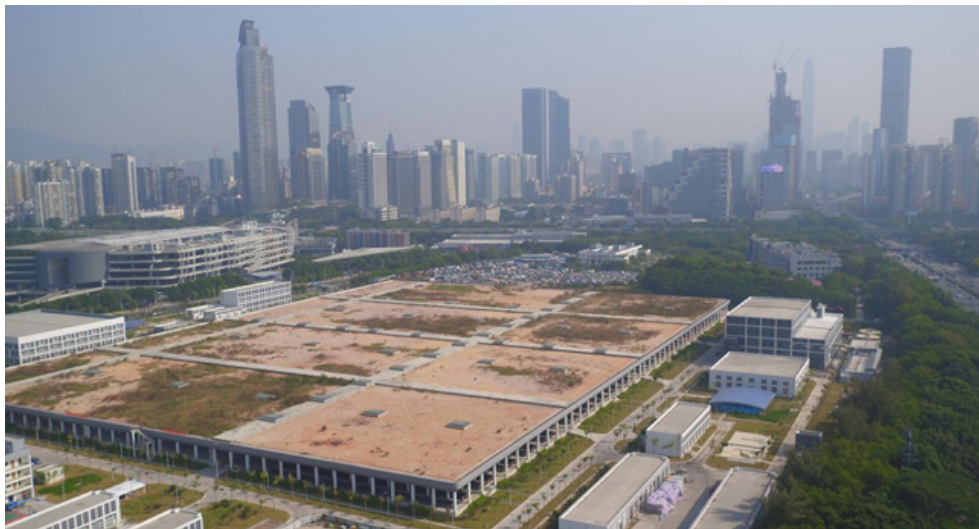
污水处理厂上盖原貌鸟瞰
